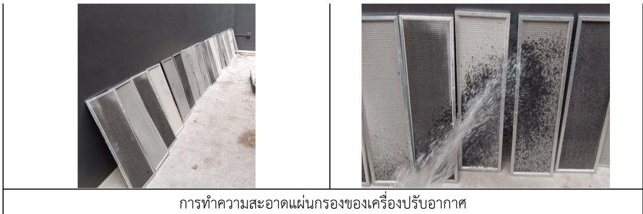
รูปที่ 2-29 การตรวจสอบและทำความสะอาดระบบปรับอากาศ (ต่อ)
