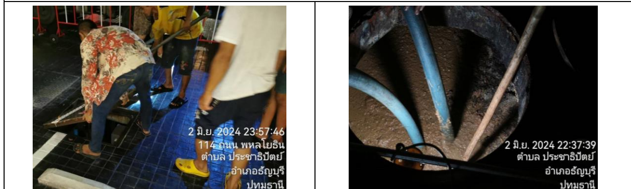
การสูบล้างและกำจัดไขมันจากระบบบำบัดน้ำเสียโครงการ
