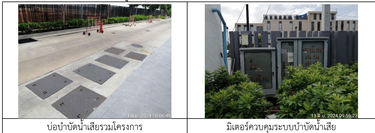
รูปที่ 2-4 ระบบของบำบัดน้ำเสียของโครงการ
